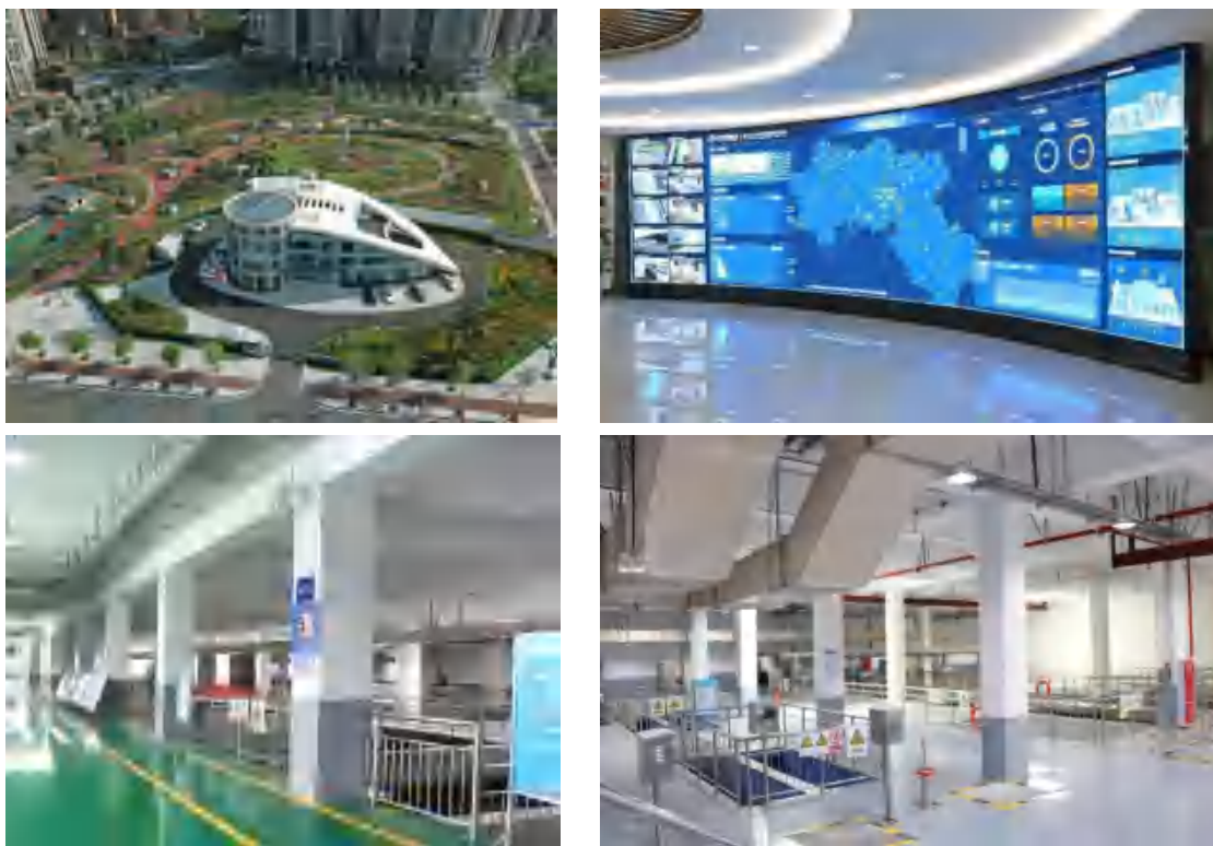
图 33—4 谢家河再生水厂实拍图
