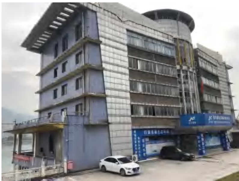
图 48—1 港航办公大楼改造前
