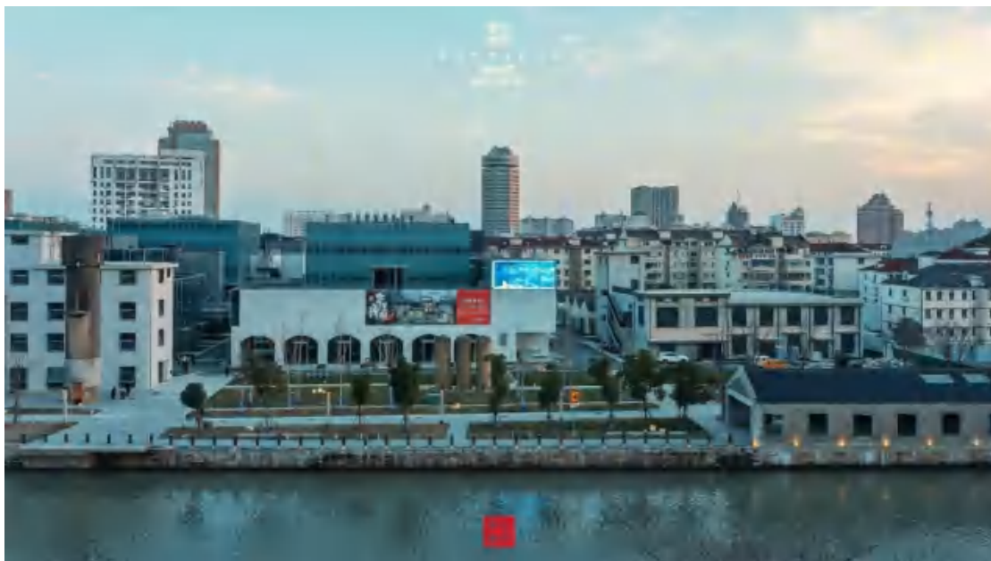
图 44—6 更新后沿河历史建筑界面
