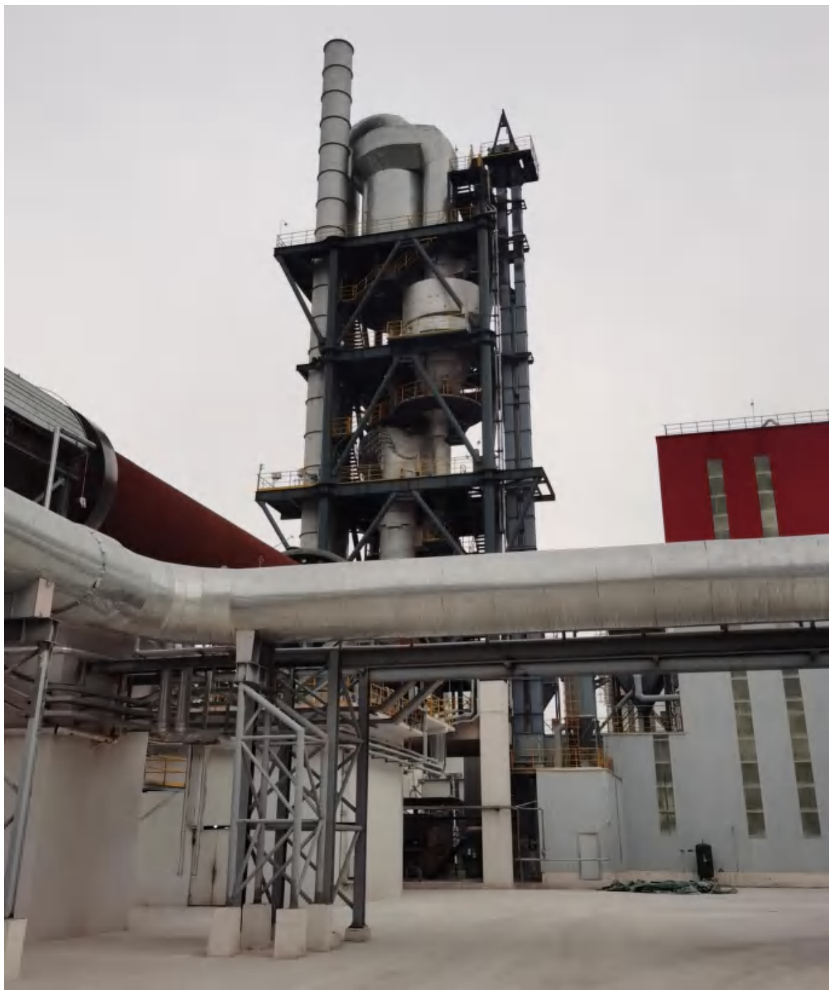
图 36—4 热工系统塔式竖向集成
