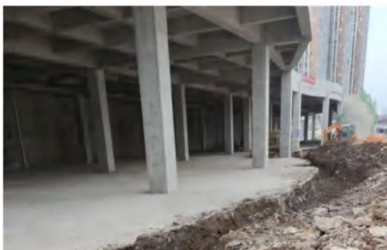
图 48—5 架空层改造前
