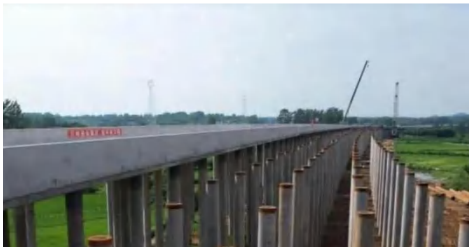
图 37—2 桩板式结构示意图
