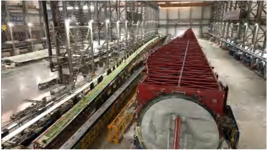
图 7—5 盘活利用后项目生产车间照片
