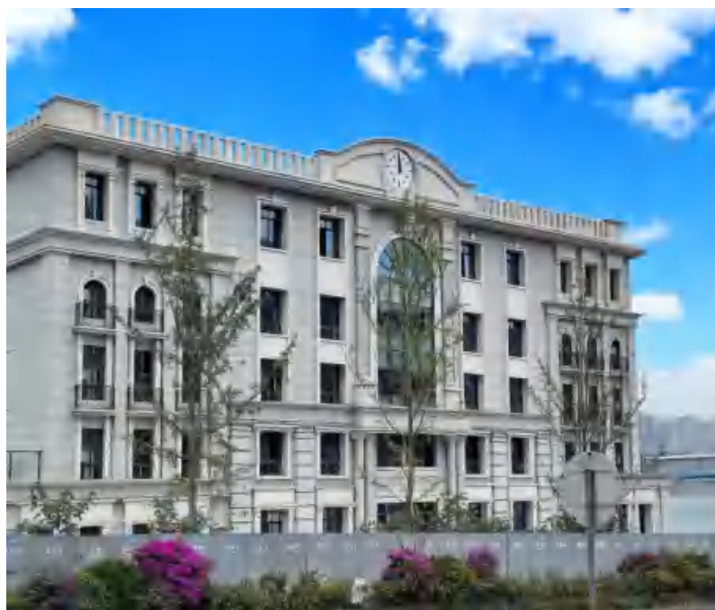
图 48—2 港航办公大楼改造后
