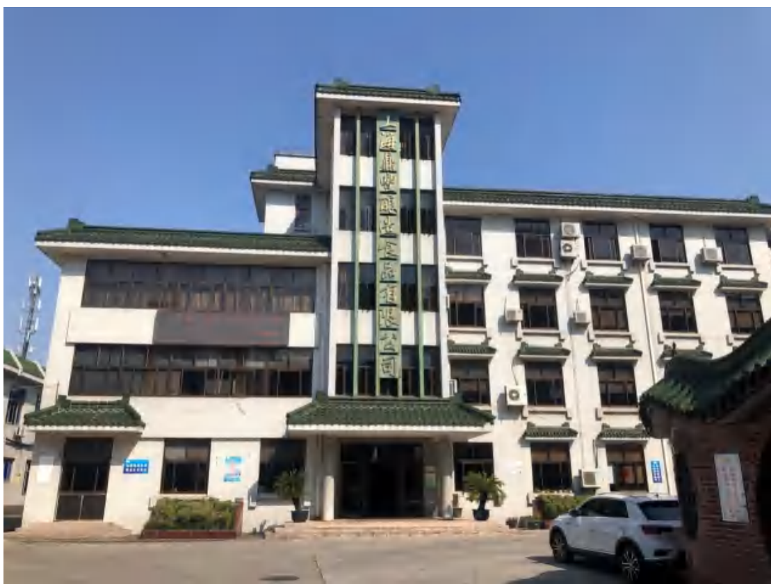
图 44—3 鼎丰厂老厂房照片
